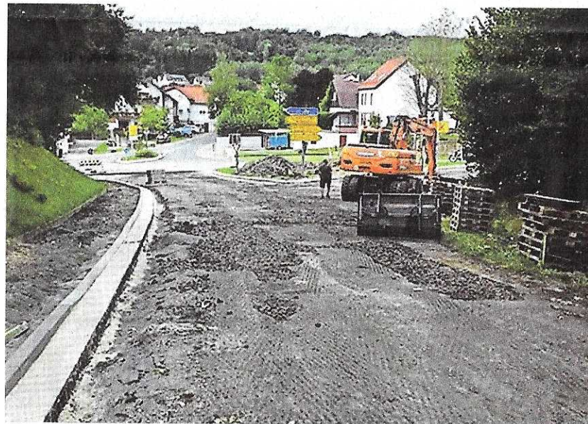
Die Bauarbeiten zwischen Neuenschmidten und Hellstein.
