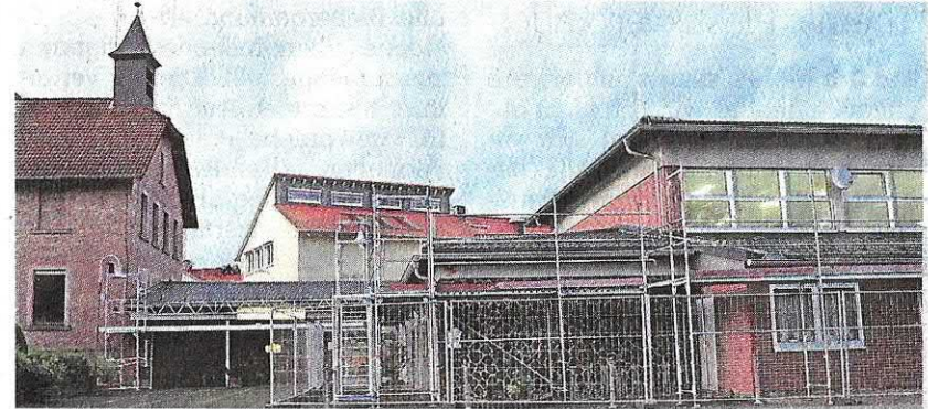
Das neue Dach der Mehrzweckhalle ist kurz vor der Fertigstellung.
